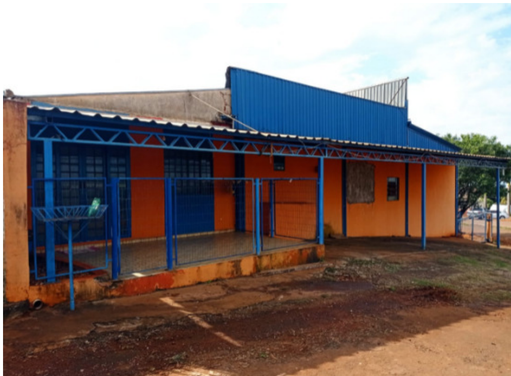
Imagens da construção residencial localizada a esquerda da imagem
